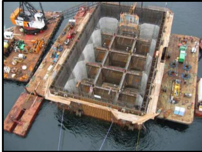
Fig.1.7. Caisson Foundation
